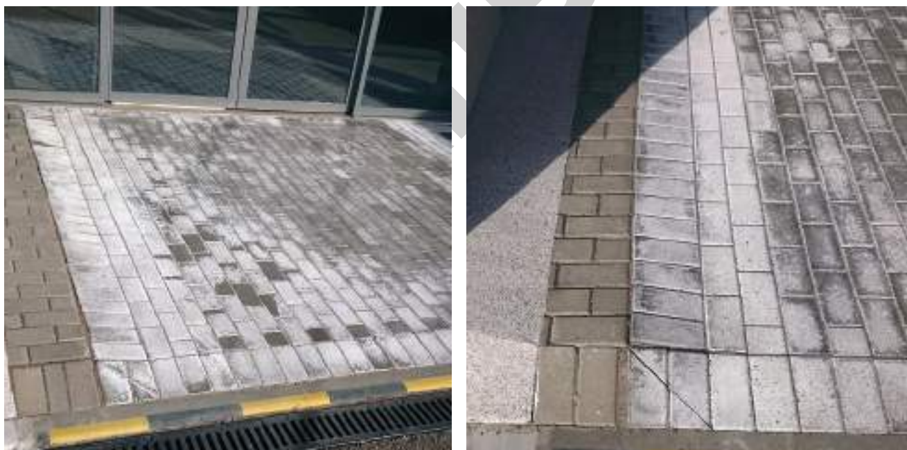
Рис. 10. Вторичные высолы на поверхности мощения.
