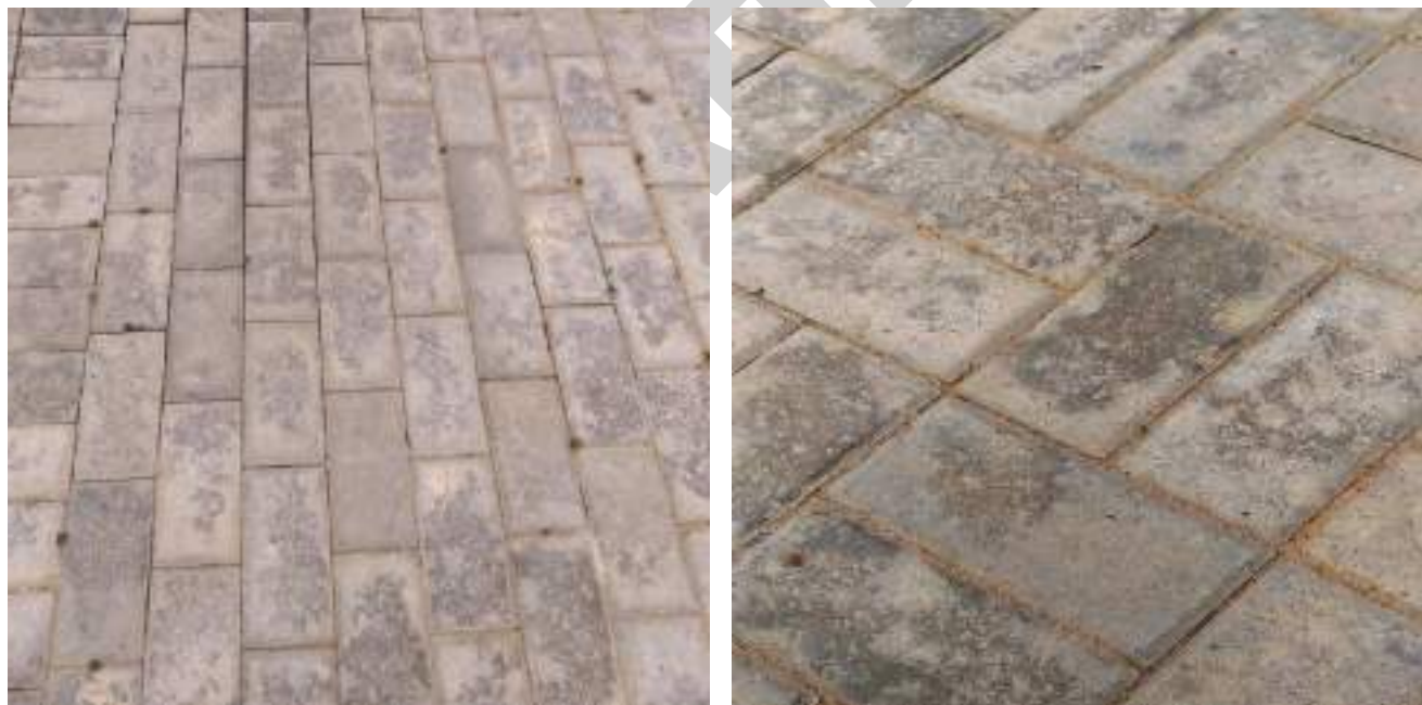
Рис. 10. Вторичные высолы на поверхности мощения.
