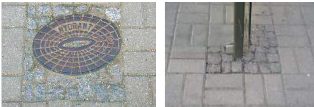
Рисунок 7.11. – Выполнение примыканий гранитными мелкоштучными камнями
